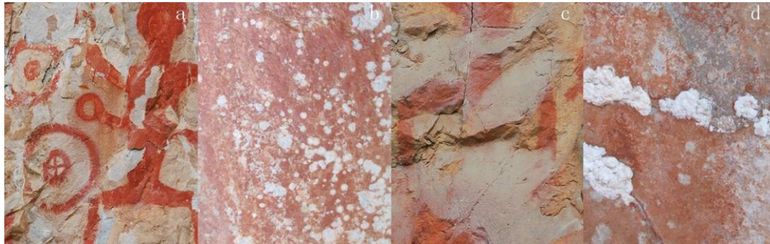
(a) Flaky rock spalling; (b) Pigment layer pulverized off; (c) Dust cover; (d) Calcium carbonate cover
